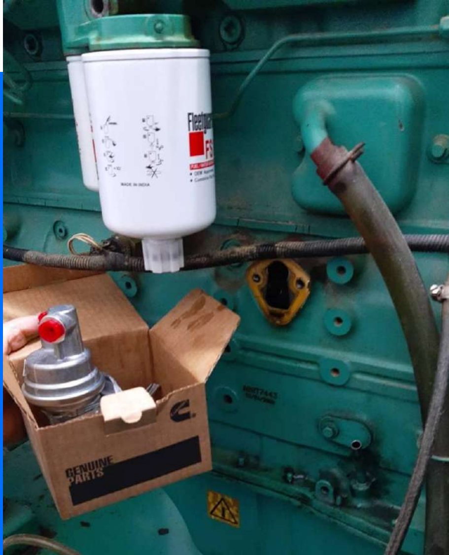
Troca de Bomba Alimentadora
